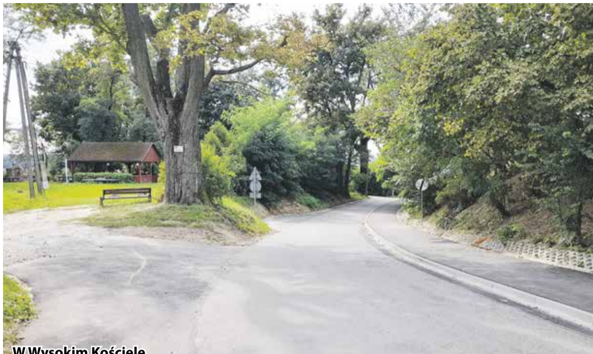
W Wysokim Kościele na ul. Zacisze został wybudowany chodnik.
