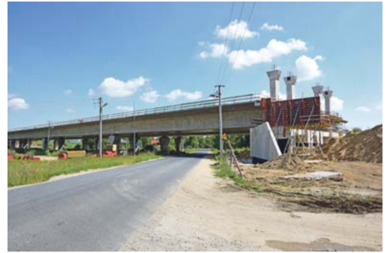
Fot. Budowa wiaduktu nad drogą z Wiszni Małej do Strzeszowa.
