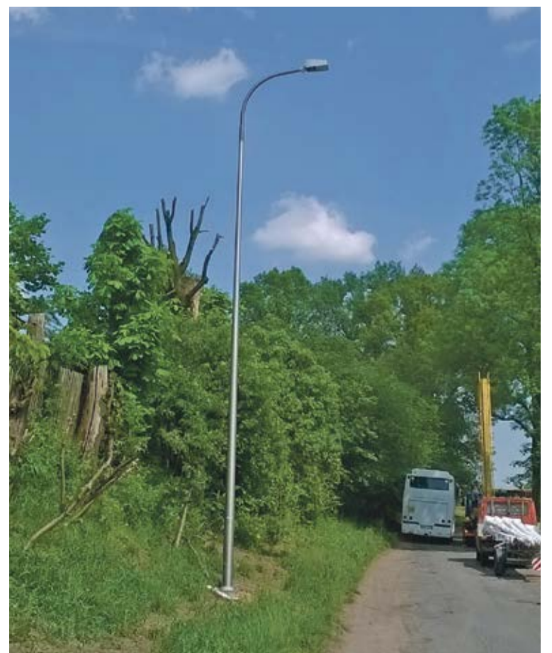
Fot. Nowa lampa zainstalowana w Mienicach.
