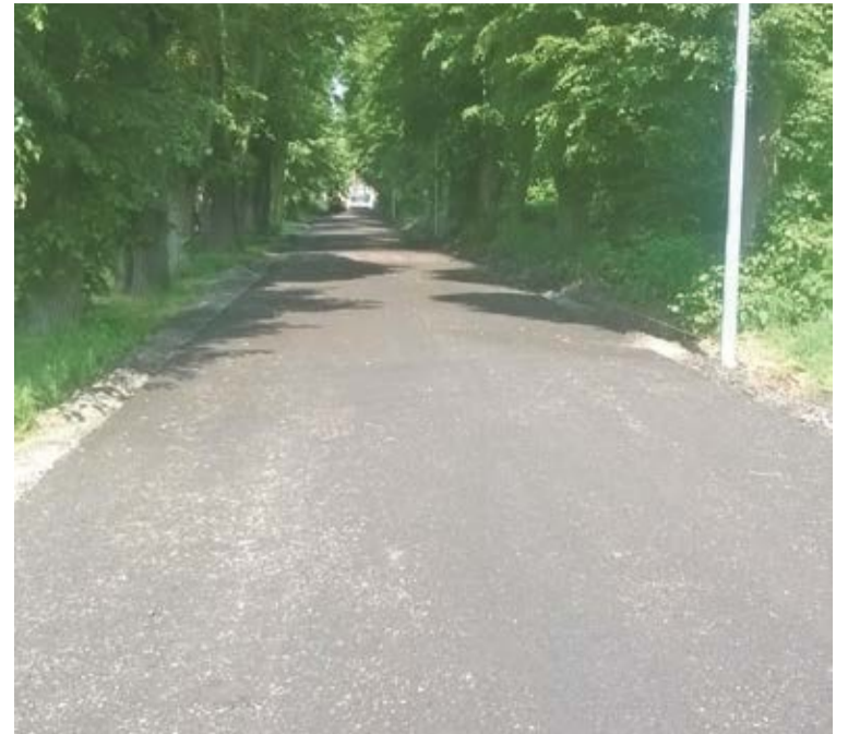
Fot. Wyremontowana ulica Łąkowa w Wiszni Małej.
