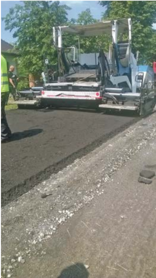
Fot. Prace remontowe na ul. Łąkowej w Wiszni Małej.
