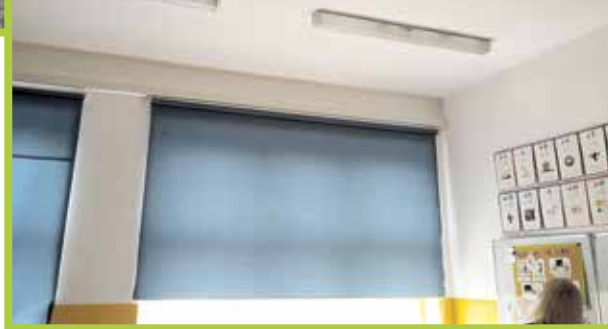
Wyremontowana sala w Zespole Szkolno-Przedszkolnym w Szewcach.
