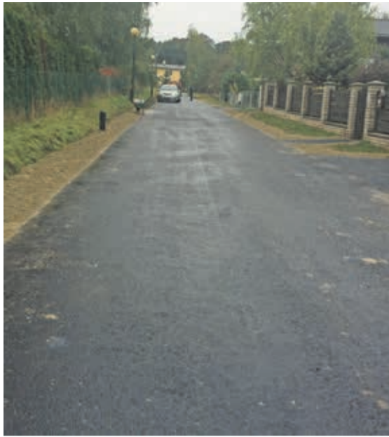
Fot. Nowa nawierzchnia asfaltowa w Malinie na ul. Słonecznej.
