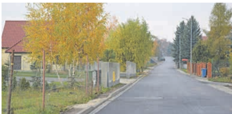
Fot. Zakończono przebudowę ulicy Długiej w Szewcach
