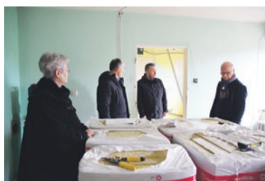
Omówienie prac remontowych na placu budowy
