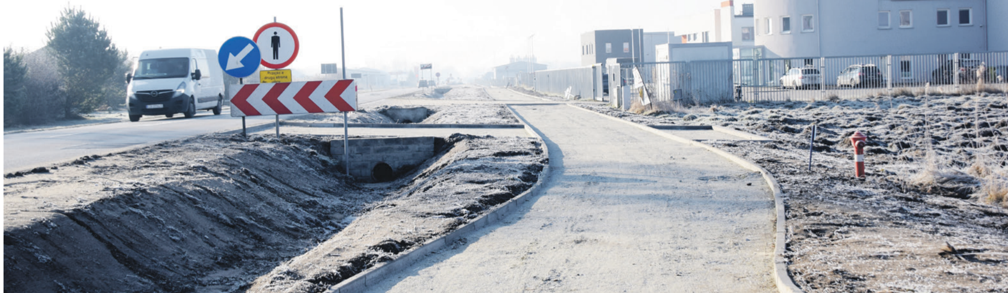
W Szewcach trwa budowa parkingu Park&Ride
