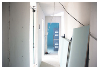
Jedno z remontowanych mieszkań w Piotrkowiczkach
