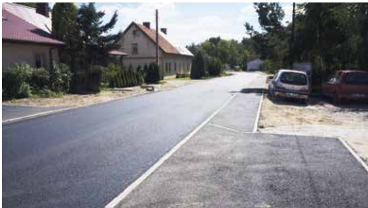
Fot. Remont drogi powiatowej w Pierwoszowie.
