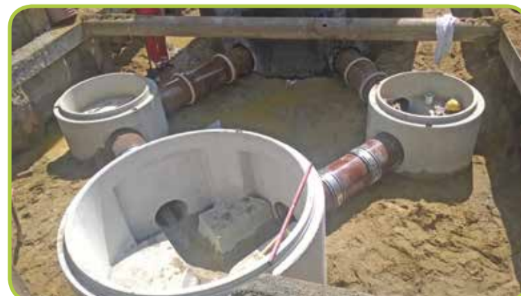
Przepompownia ścieków w Psarach
